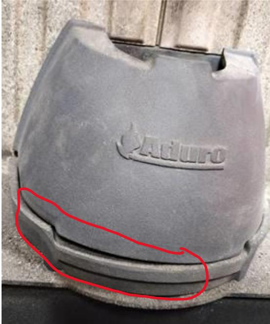
Revisar la Junta que hay bajo el brasero. Verificar especialmente que los rincones están bien ajustados. La HPJunta debe estar colocada en el borde de la base en la zona indicada en la foto y los rincones deben encajar perfectamente.
