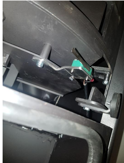
Nuovo supporto ed interruttore montati
