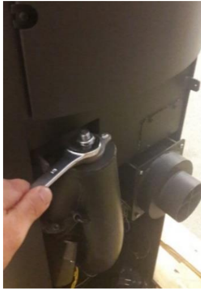
Figura 4: svitare leggermente il dado di fissaggio della coclea
