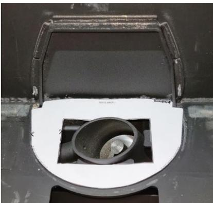
Entfernen Sie den Schutzfilm von der Dichtung und bringen Sie diese entlang der Außenkante der Schablone an:
