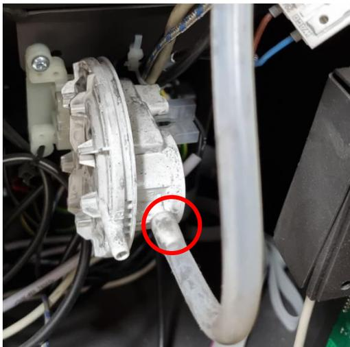
3. Drücken Sie die zwei markierten Haken, um den Druckschalter von der Plastikhalterung zu lösen.
