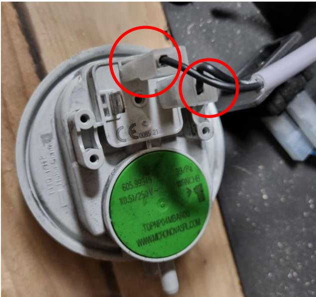
5. Verbinden Sie die Kabel mit dem neuen Druckschalter und setzen Sie diesen wieder in seine Plastikhalterung. Sie den Schlauch wieder auf den Druckschalter.
