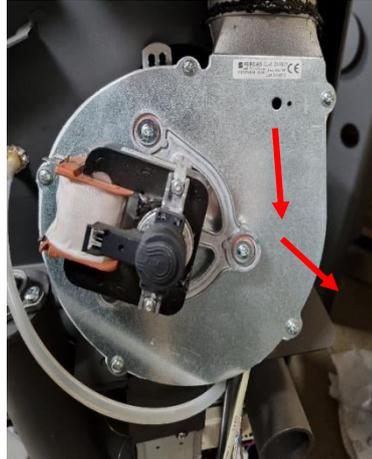
5. Bringen Sie nun hitzebeständiges Silikon an dem neuen Gebläse an (wie auf dem Bild zu sehen). Montieren Sie nun das neue Gebläse wie dargestellt:
