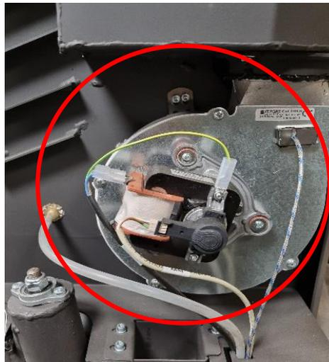
1. Entfernen Sie den Rauchtemperatursensor vom Gebläse, indem Sie die Metallabdeckung entfernen und vorsichtig am Kabel ziehen. Entfernen Sie den Filz und lösen Sie die Kreuzschraube um den Sensor und die Platte zu entfernen:
