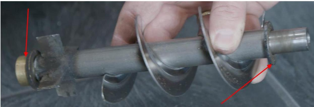
7. Befestigen Sie die Teile an der neuen Schnecke und setzen Sie die Schnecke wieder in das Pelletrohr des Ofens ein. Befestigen Sie dann die Platte wieder mit den Schrauben:
