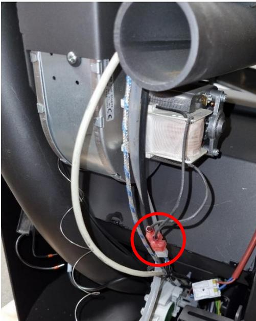
3. Retirer les trois vis qui maintiennent le support du ventilateur en place, puis retirer le connecteur du ventilateur :
