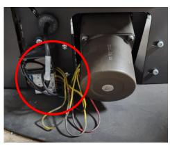
3. Dévisser les quatre vis de la plaque arrière du poêle et retirer la plaque arrière. Retirer ensuite l'écrou du filetage extérieur de la vis, dévisser les deux vis sur les côtés et retirer le roulement :
