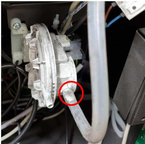
3. Retirer le pressostat de l'attache en plastique qui le tient en place en appuyant sur les deux crochets en plastique :
