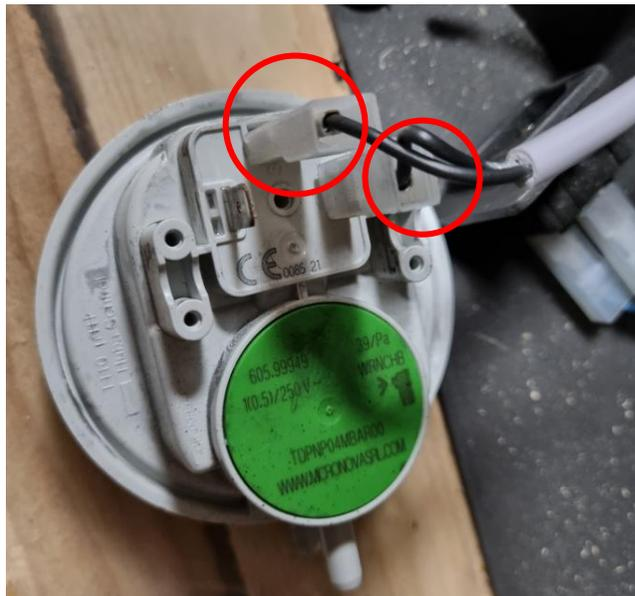
5. Reconnecter les connecteurs au pressostat en les enfonçant dans l'attache en plastique, puis replacer le tube.
