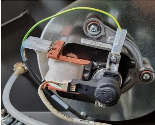
9. Avant de remonter la plaque arrière, nous vous recommandons d'effectuer un allumage pour vérifier que le nouveau ventilateur extracteur fonctionne. Si cela est le cas, remontez la plaque arrière.
